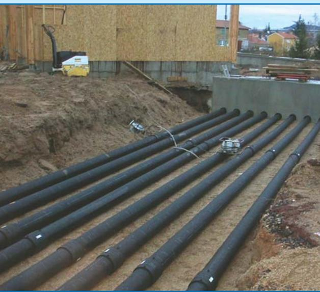
**Le puits canadien ou comment réduire la température intérieure de quelques degrés dans le bâtiment en été et diminuer sa consommation de chauffage en hiver.**
